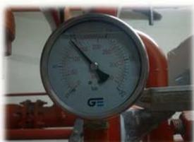
**PRESIÓN CON BOMBAS PRINCIPALES EN FUNCIONAMIENTO (10 kg/cm<sup>2</sup>).**
